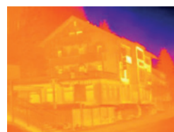
Wärmebild ohne testo ScaleAssist
